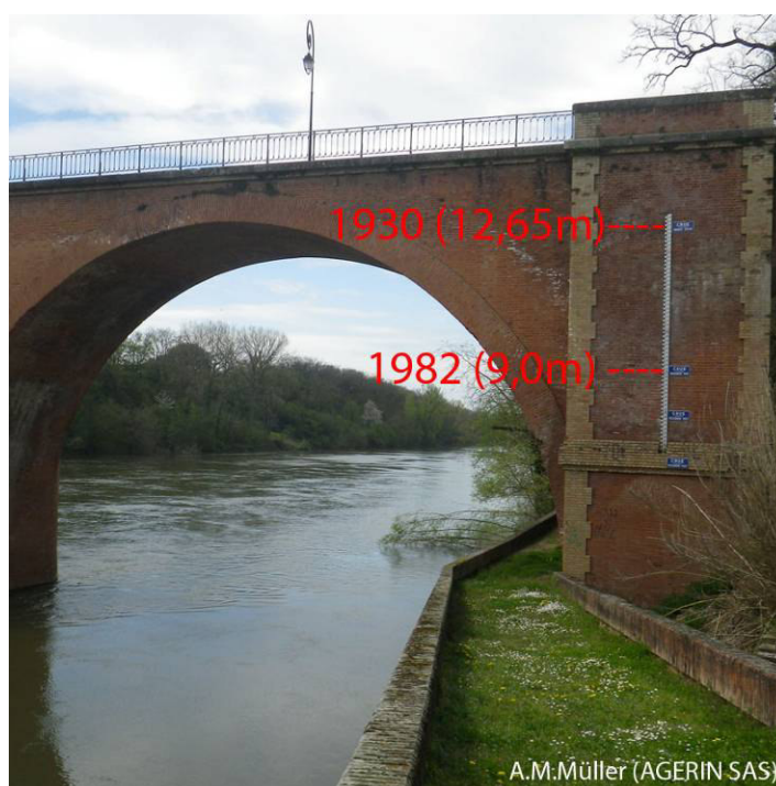
Figure 12 : Repères de crue sur le pont de Reynies. Cliché AGERIN SAS
