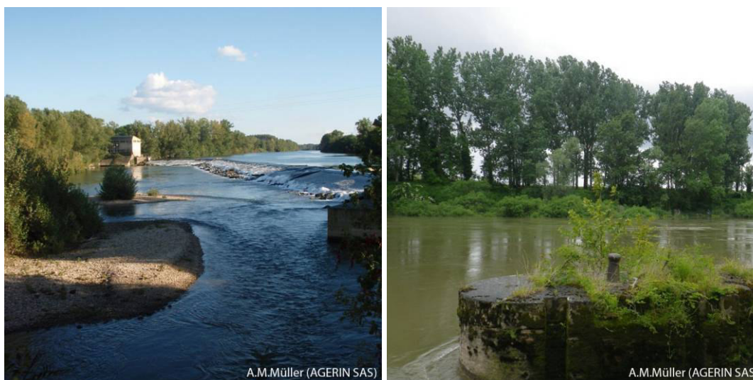
Figure 14 : Seuil de Lagarde à l'étiage et restes de l'écluse du barrage effacé de la Pointe Clichés : AGERIN SAS
