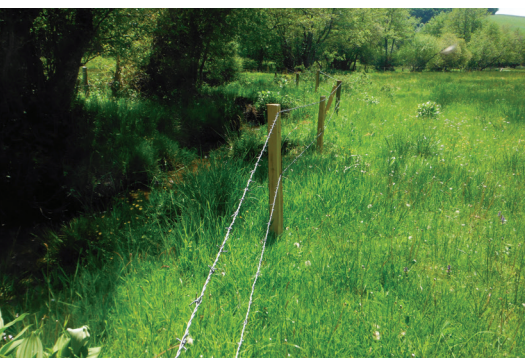
Pose de clôture en bord de cours d'eau
