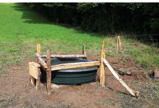
Mise en place d'un point d'abreuvement hors cours d'eau
