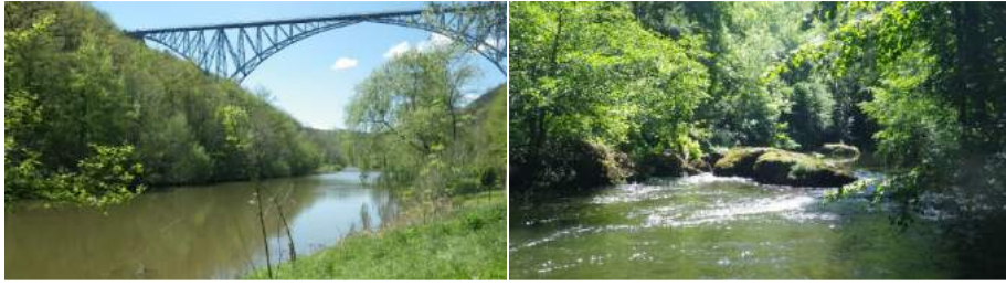
Figure 10 : Chenal lentique (en amont du Viaduc du Viaur) & chenal lotique (en amont du pont de Thuriès)
