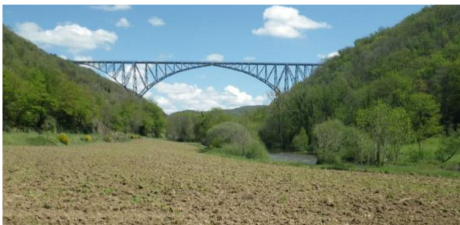
Figure 8 : Le Viaduc du Viaur surplombant la vallée à fond plat à proximité de Tanus
